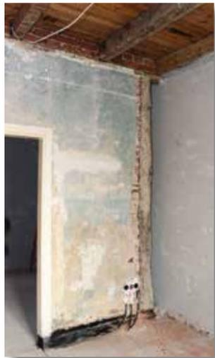
Im Dorfbüro wurde bereits mit dem Innenausbau begonnen. Während einige Wände bereits verputzt sind, ragen aus anderen Anschlüsse heraus.
