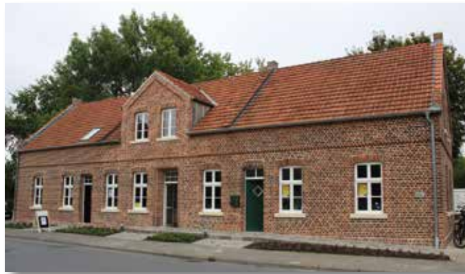
Die Umbauarbeiten im Läutehaus an der Ahlener Straße sind weiterhin im vollen Gange.
