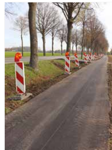
Der Radweg entlang der Kreisstraße 20 wurde Anfang November teilweise saniert.
