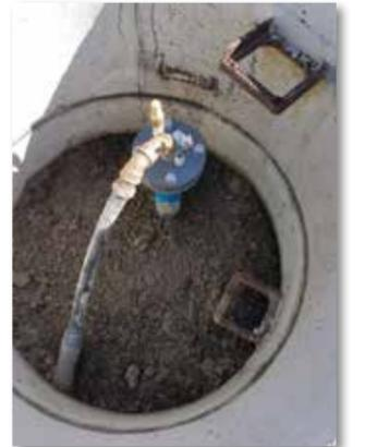
Brunnen mit Schutzrohr und wasserdichtem Anschlusskopf für die Gewinnung von Trinkwasser.
